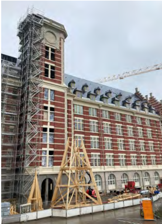
Montage de la flèche sur le chantier de réhabilitation
