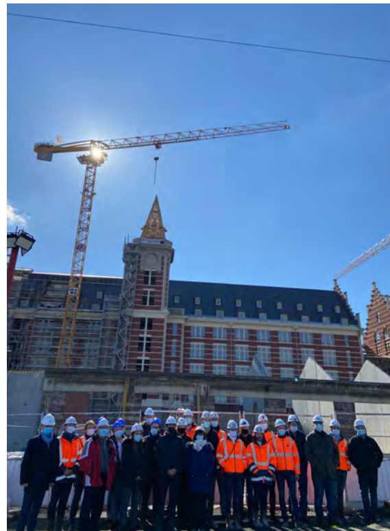
Pose de la nouvelle flèche des Grands Moulins de Paris
