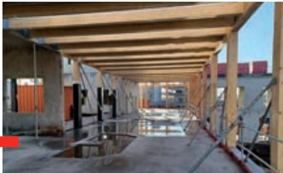
Nos compagnons ont remplacé le béton par la pose de poteaux, poutres et planchers en bois sur le chantier de la **clinique Elsan à Maizières-Lès-Metz**.
