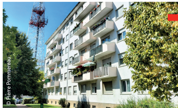
Réhabilitation de la Cité Lauth, Strasbourg
